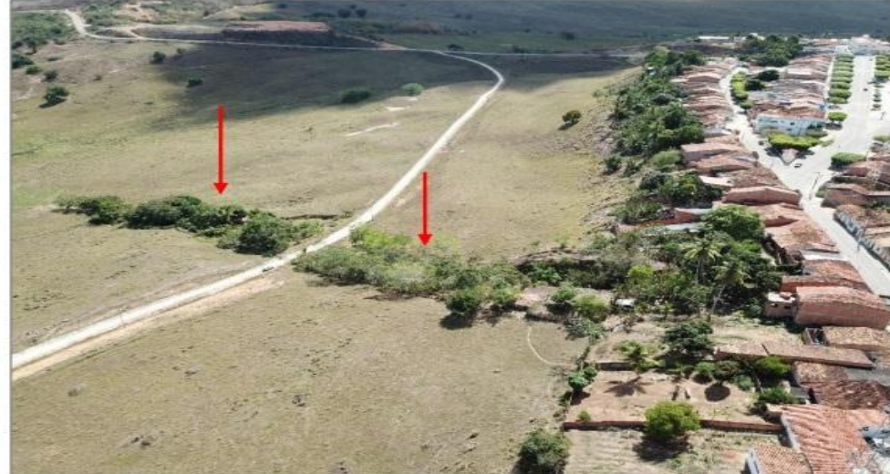
Figura 6 – Área de ocorrência dos processos erosivos. UTM 24 L E702223/N8819141, 19/12/2018.
