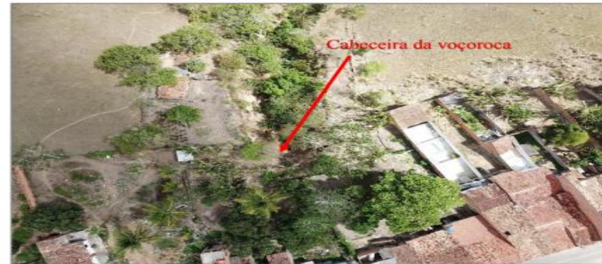
Figura 19 – Área de Risco com residências próximas. UTM 24 L E702364/N8819097. 19/12/2019.
