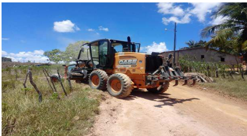
Retirada de Material para recuperação de estradas
