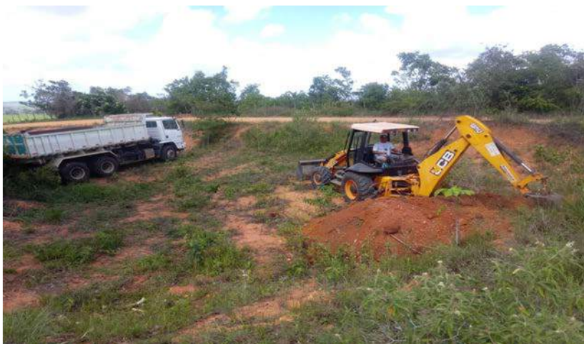
Retirada de Material para recuperação de estradas
